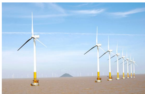
图 1 东海大桥海上风电工程
